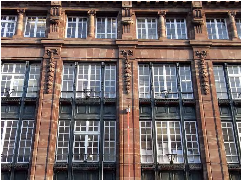
Strasbourg, Kaufhaus Modern , 1913-14, par la suite "Magmod", aujourd'hui "Galeries Lafayette", J. Berninger & G. Krafft architectes, façade sur la Rue du 22-Novembre, proche du projet de H.Billing. Photo Klaus Nohlen, 2010.
