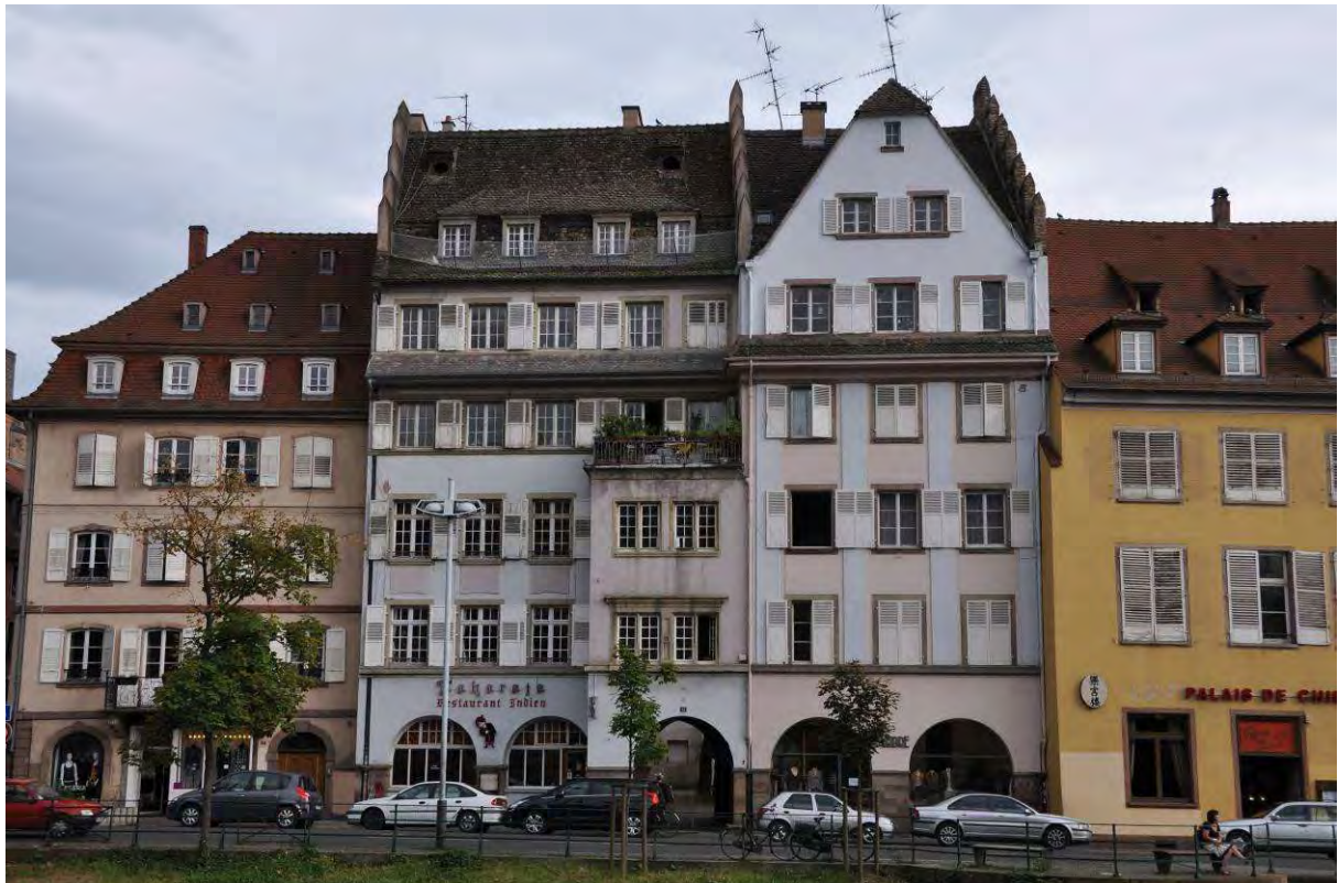
Strasbourg, 15-16, quai des Bateliers, immeuble, par F. Beblo, 1911. Edifié à l'emplacement de trois anciennes maisons, Beblo intégra parfaitement l'immeuble au tissu urbain voisin, en reproduisant un décrochement. Il s'inspira à la fois de l'état ancien, des hautes maisons médiévales strasbourgeoises (pignons à redents), et de la Renaissance (oriel). Photo O. Haegel © Région Alsace – Inventaire général, 2008.
