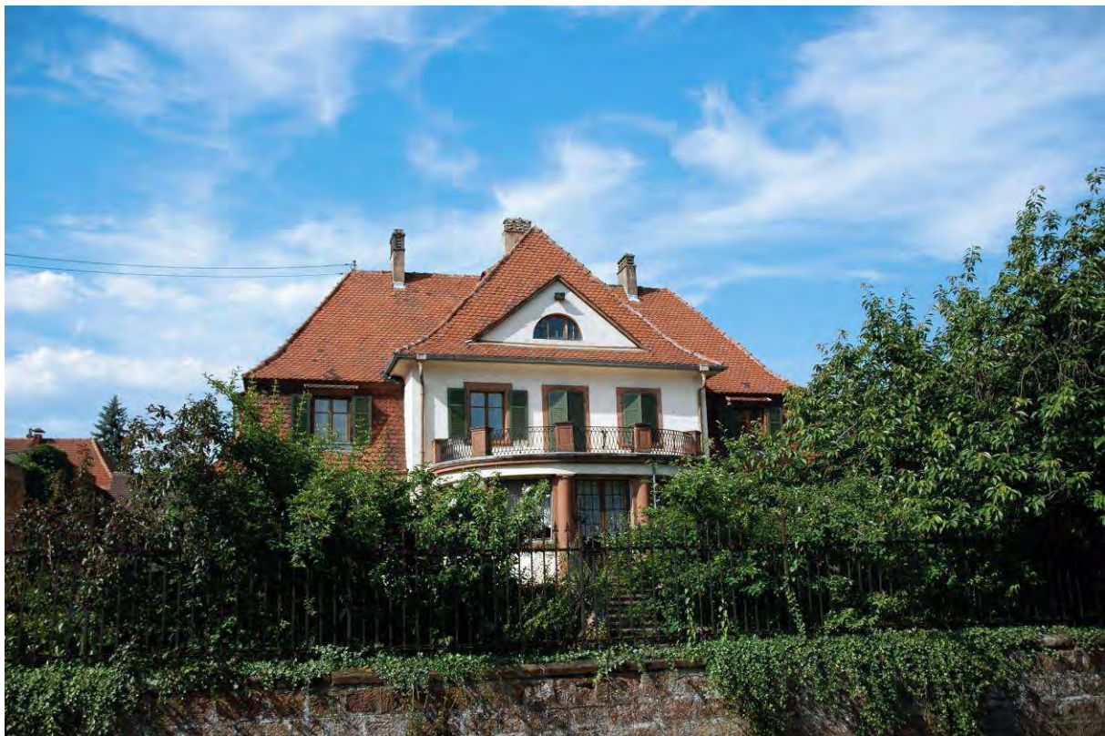
Ingwiller, maison von Roeder, par T. Berst, 1910. Exemple illustrant les emprunts à l'architecture de la fin du XVIII e siècle et du début du XIX e siècle. Ici implantée en milieu rural, ce genre d'exemple se trouve usuellement implantée dans les faubourgs résidentiels alors en cours de développement. Photo J. Raimbault © Région Alsace – Inventaire général, 2008.
