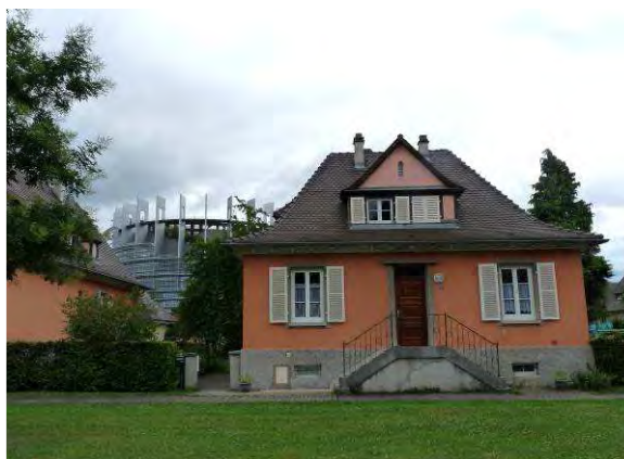
Vue actuelle sur une maison-type A. Photo Maurice Moszberger.
