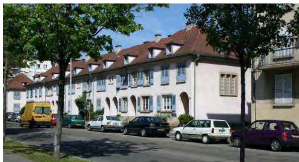
Vue de l'ensemble du quai des Alpes, Photo H. Doucet
