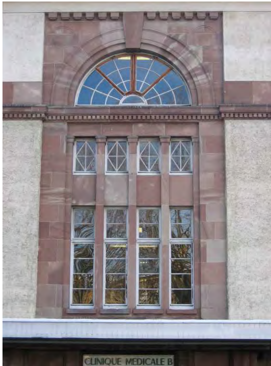
Hôpital de Strasbourg, Clinique médicale B, 1914, fenêtre surplombant l'entrée principale, P. et K. Bonatz architectes. Photo Klaus Nohlen, 2001.
