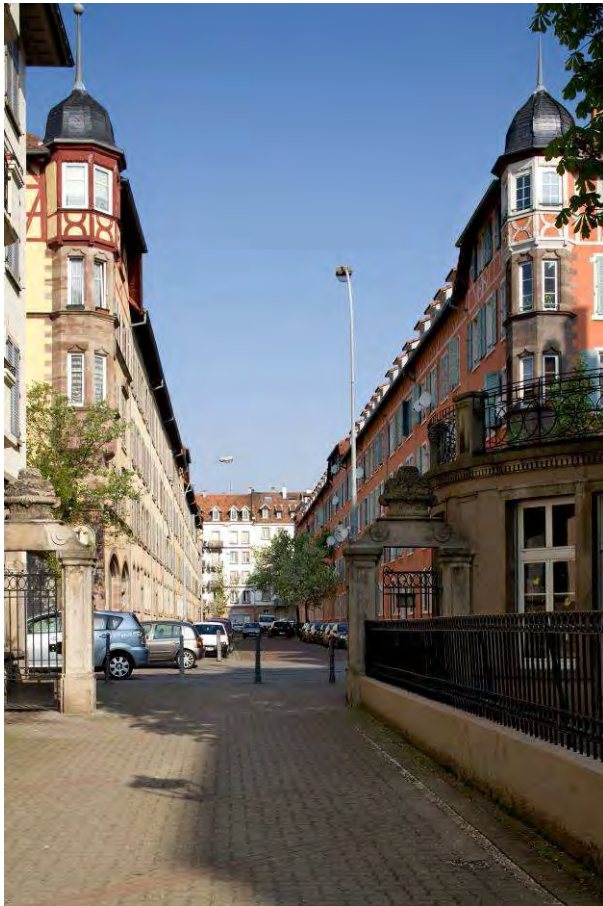
Vue de la cité Spach et de l'immeuble de la Gemeinnützige Baugesellschaft . Photo Claude Menninger, Service de l'Inventaire et du Patrimoine, Région Alsace.
