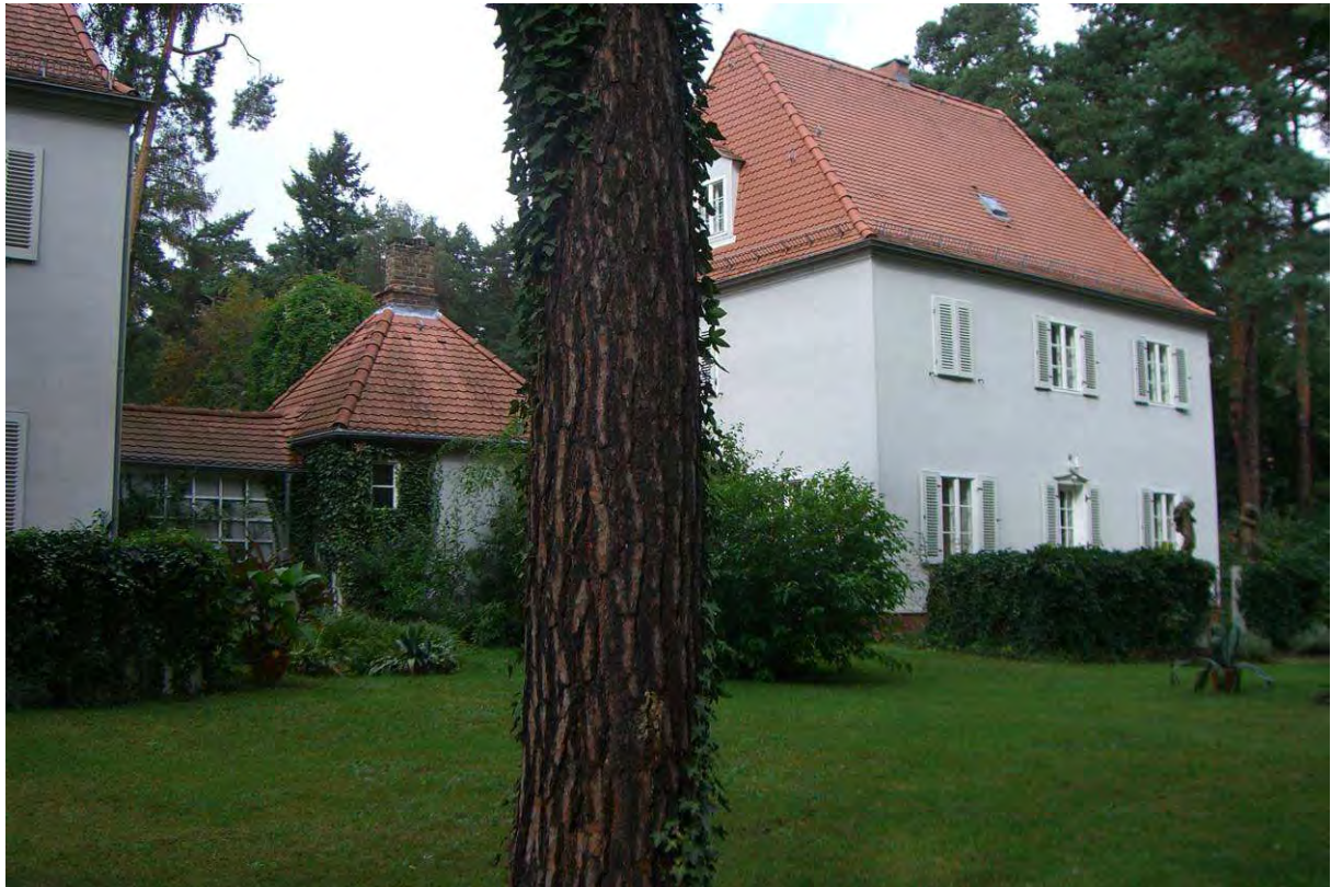
Les villas jumelles Heideweg 24-26, Heinrich Tessenow architecte, Photo Anne Mariotte/Claire Kuschnig
